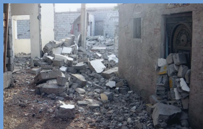
Daños causados por un ataque aéreo en Adén, Yemen (2016, Mwatana)
